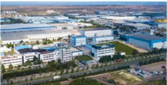
ÇERKEZKÖY IV Logistics Center
